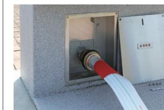
ボックス内には、断水時に給水用ホースを接続する接手 (継ぎ手) が組み込まれています。本体には常用と非常時の2系統の給水管を併設しています。ボックスは南京錠で管理いただく仕様になっています。
