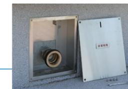
断水時にはこの接手 (継ぎ手) に給水用ホースを接続します。
