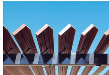
ルーバーは200mmピッチで設置し、ルーバー同士の平面投影隙間は約40mmとなっています。パーゴラのイメージを残しつつ適度な隙間を確保しているため風通しも良く、屋根に熱が滞留することも少ないので下部空間を快適にします。
