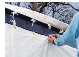
屋根の上にのぼらなくてもテントの設営ができるよう、安全面に配慮しています。テントは桁外周の丸鋼にひもで結び、取り付けていきます。
